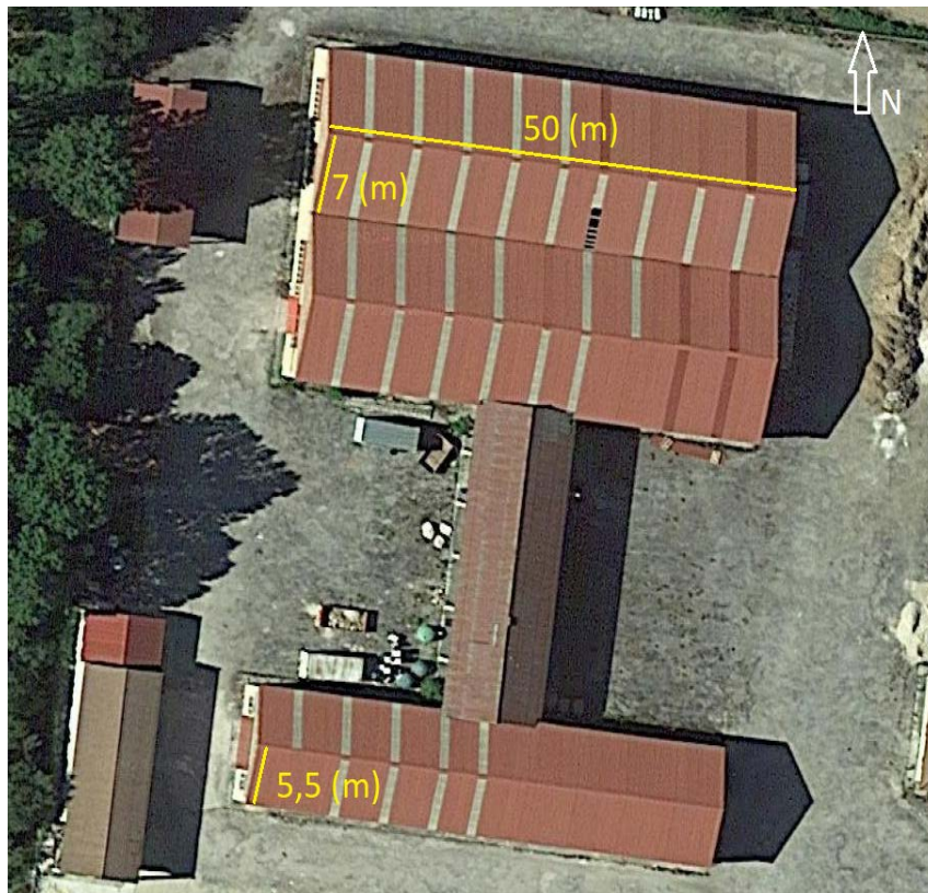
Figura 4. Cubiertas del ferial.
