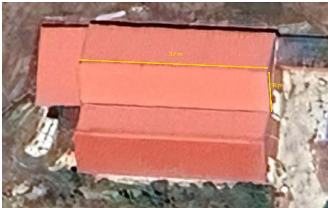
Figura 10. Cubierta nave Cueva
