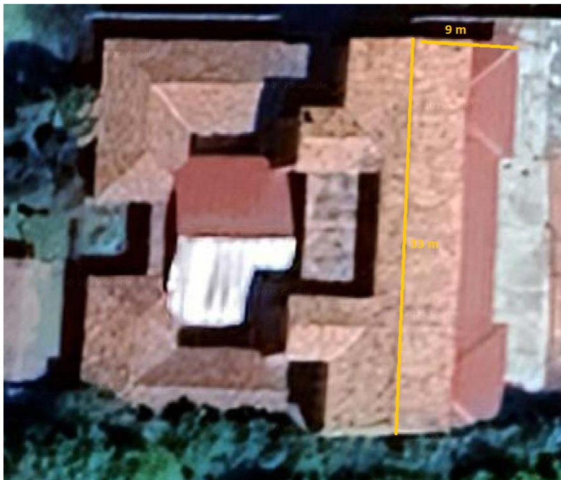
Figura 14. Cubierta colegio Oña.
