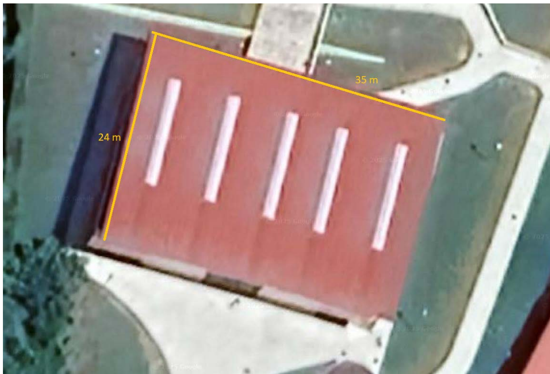
Figura 16. Cubierta multicenter Quintana Martín-Galíndez.
